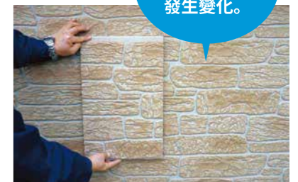
●使用塗裝色標準板進行退色和劣化的檢查
