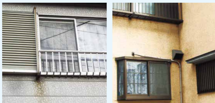
附著在灰漿等其他外壁材料上的污垢例
